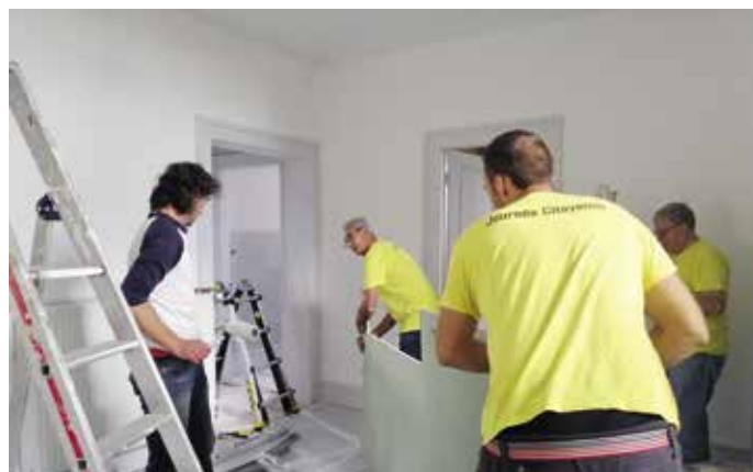
Travaux dans la Maison des Associations
