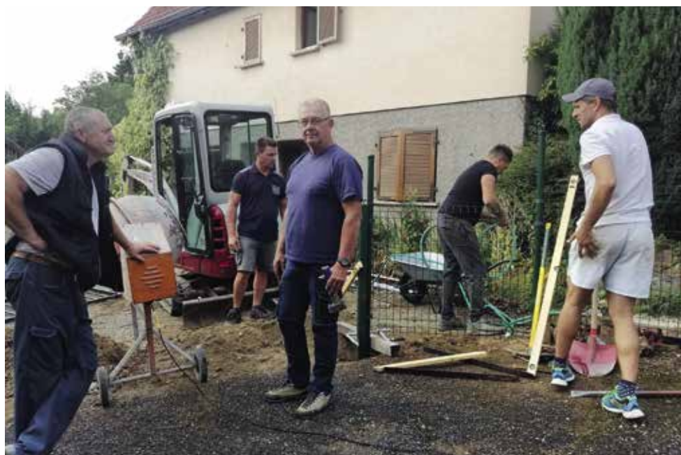
Mise en place portail maison forestière
