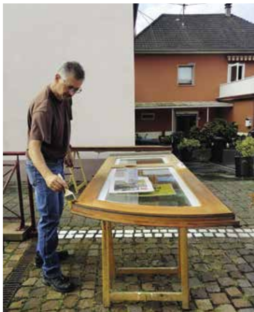
Ponçage et lasure de la porte de la boulangerie
