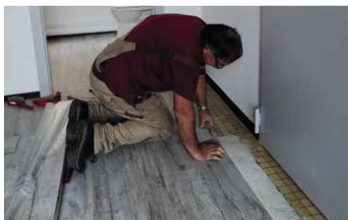
Pose du revêtement de sol au cabinet médical
