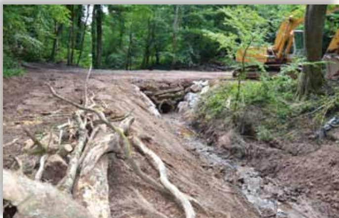
Réfection du pont sur le Quirenbach
