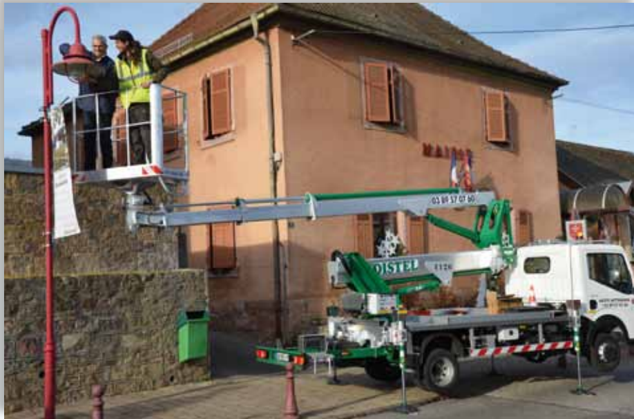
Mise en place de lampes à LED pour l'éclairage public
