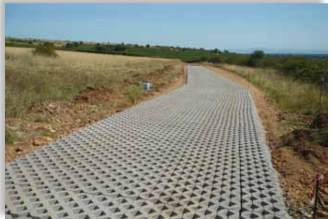
Réfection du chemin rural d'Orschwihr à Rouffach et pose de pavés alvéolés
