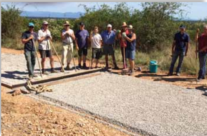
Réfection du chemin rural d'Orschwihr à Rouffach et pose de pavés alvéolés
