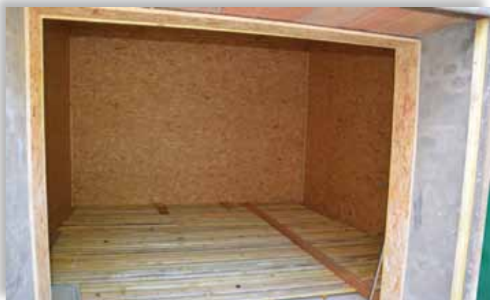
Réalisation d'un nouveau local pour la crèche
